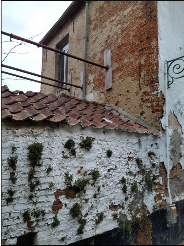
Figuur 5. Tuinmuren als 'early warning' voor het vorstschaderisico van de baksteen (Begijnhof, Lier).
