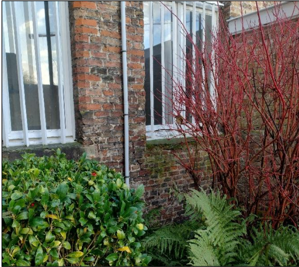
Figuur 1. Onaangepaste druiplijstdetailering van een buitendorpel. Sterke bevochtiging en vervuiling van de zone onder de dorpel ( Sint-Godelieveabdij, Brugge)
