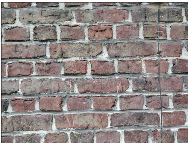
Figuur 9. Macro-scheuren in de baksteen vormen een belangrijk risico op vorstschade (Paterskerk, Roeselare).
