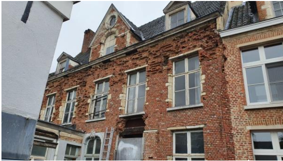
Figuur 7. Uitgebreide nood aan vervanging van de baksteen (Convent Begijnhof, Antwerpen).
