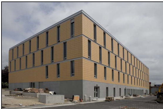
Zuid- en westgerichte gevels met kleine raamopeningen en zonnewering (individuele kantoren)
