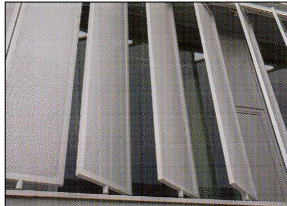
Detail van de mobiele buitenzonnewering (geperforeerde metaalpanelen) op oostgerichte gevel
